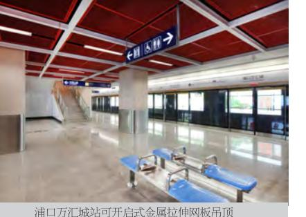
浦口万汇城站可开启式金属拉伸网板吊顶
