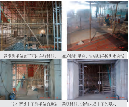
满堂脚手架构的搭设，既要满足精装修的需要，又要同时考虑9米高活动隔断的安装，为此采用分区搭设的方案，分区之间就是留给活动隔断施工的空间。安装隔断轨道时，此区域满铺脚手板，安装隔断时拆除脚手板。这样安排有利于满足总工期计划的实现。
