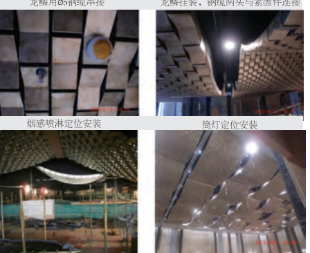
龙鳞挂装，钢绳两端与钢架固定
