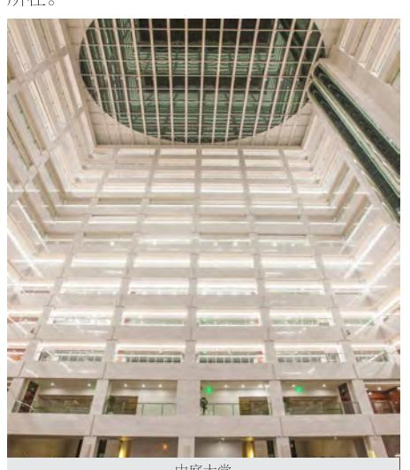
中庭墙面和柱面均为银丝白石材，为保证施工质量，本次干挂采用背栓施工工艺，合理提高工效，降低现场粉尘污染，两侧大墙面每3层位置设置水平伸缩缝，防止结构沉降带来石材断裂。另外因为银丝白石材用量近2万平方，为保证颜色统一，项目部安排采购团队进驻福建水头和广东云浮，收集约5万平米A级货源，优中选优，在加工方面请国内一流石材厂家进行深化排版，我公司项目部全程安排专人驻厂，把控加工全过程，保证了石材的品质和整体工程的效果。
